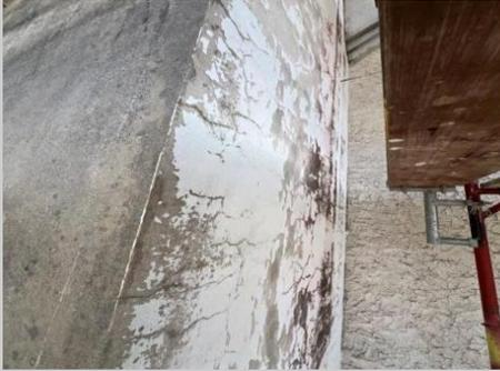
*Massive Risse, Algen- und Moos-Schäden auf fast allen Flächen, die durch Zuwarten stärker werden und in der Folge wesentlich aufwändiger saniert werden müssten.*
